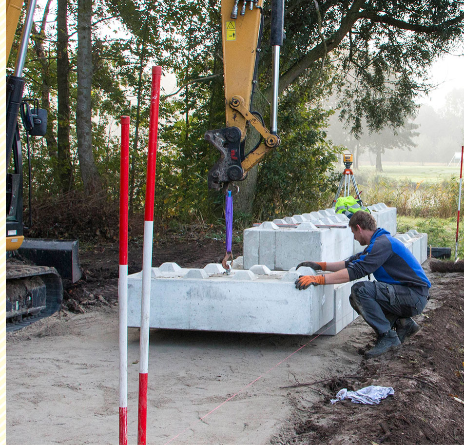
Hier kun je goed zien hoe nauwkeurig wordt gewerkt
