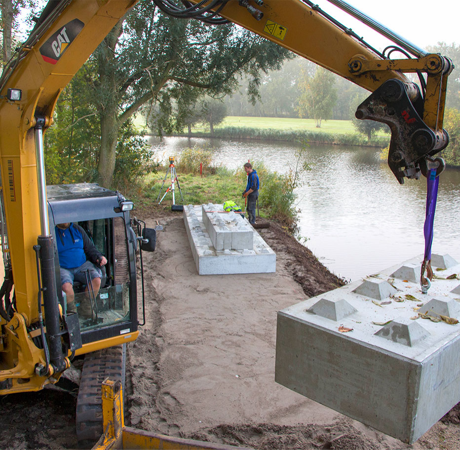
De bouw van de zwaluwwand is in volle gang
